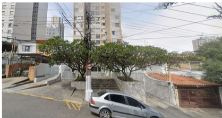
figura 1 - fachada do edifício
