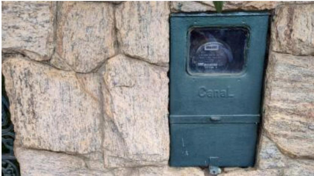
Medidor de energia elétrica
