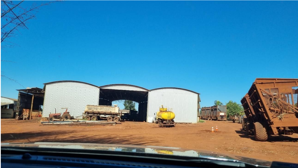
Foto 04: Galpão Fazenda Santa Emília
