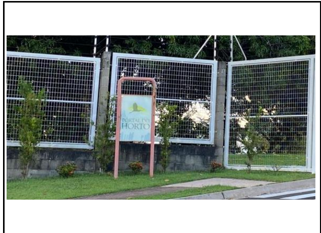
VISTA DA IDENTIFICAÇÃO DO CONDOMÍNIO
