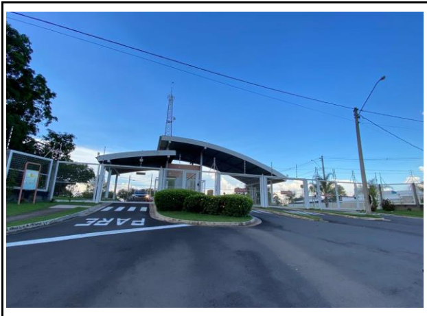
VISTA DA PORTARIA
