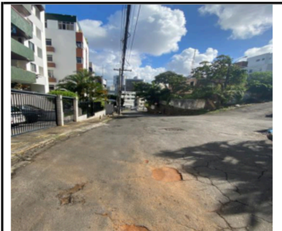
FOTO RUA VISÃO À ESQUERDA
