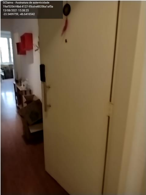
Porta de acesso a unidade
