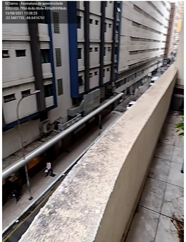
Vista para o logradouro
