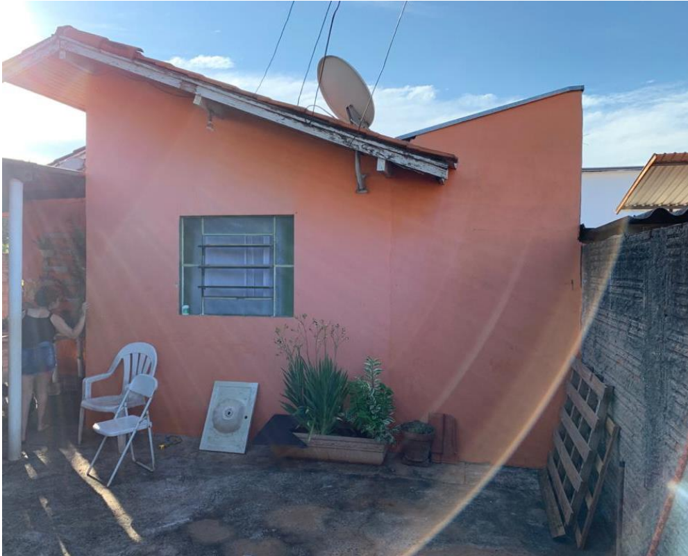
FOTO 3: Frente do imóvel:
