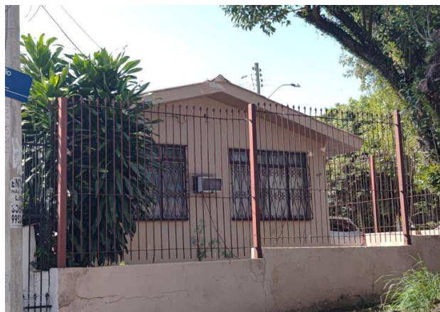
Fachada do imóvel avaliando
