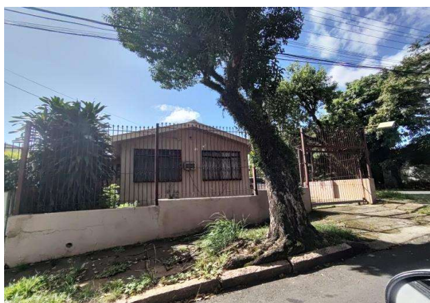
Fachada do imóvel avaliando
