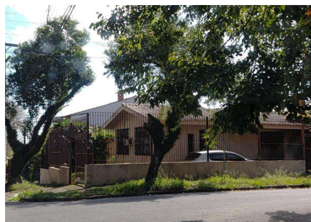
Fachada do imóvel avaliando
