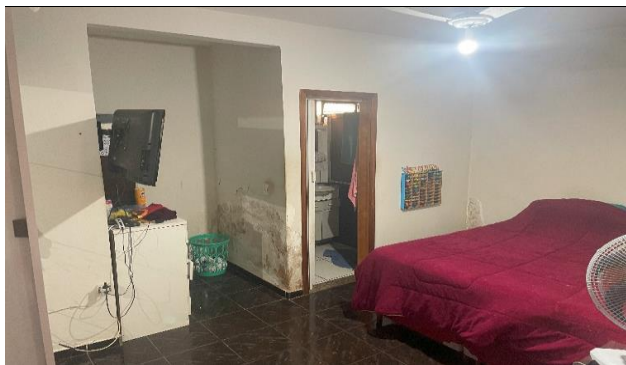
Descrição: Dormitório (suite)
