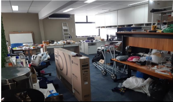
Descrição: VISTA INTERNA DA SALA
