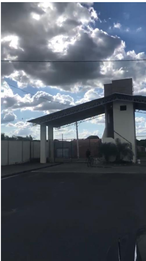
Portaria - vista interna
