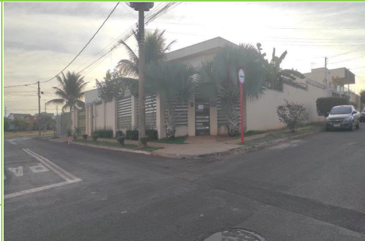
Foto da Fachada do Imóvel
