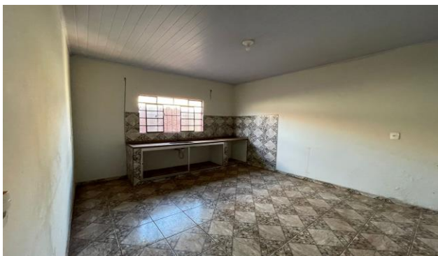
Descrição: VISTA PARCIAL INTERNA DO IMÓVEL
