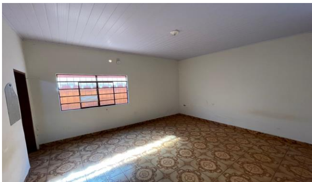
Descrição: VISTA PARCIAL INTERNA DO IMÓVEL
