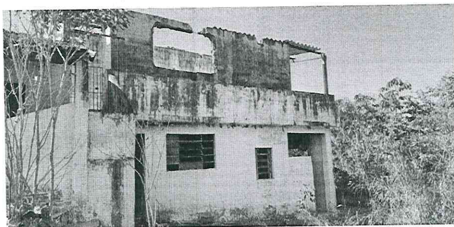
Foto 23: Vista da construção anexa a casa principal
