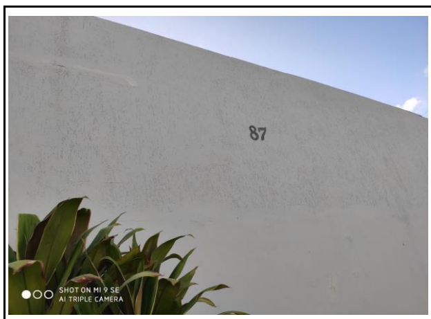
VISTA DA IDENTIFICAÇÃO NUMÉRICA
