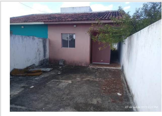
Vizinho à direita - Fachada
