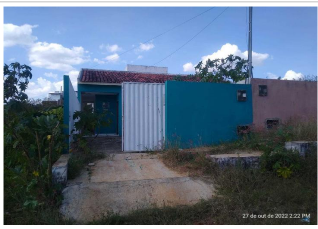
Fachada do avaliando
