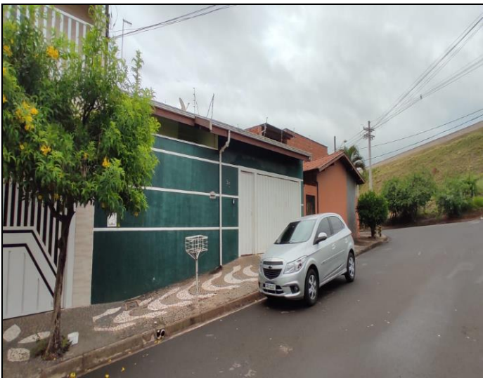
VISTA DA FACHADA DO IMÓVEL EM ESTUDO
