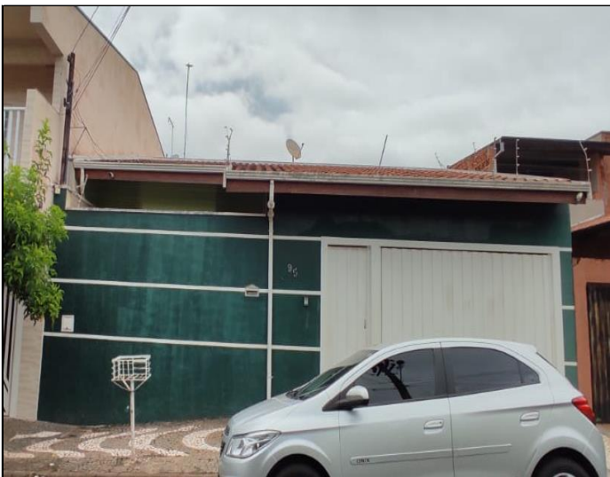
VISTA DA FACHADA DO IMÓVEL EM ESTUDO
