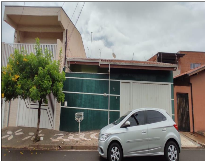
VISTA DA FACHADA DO IMÓVEL EM ESTUDO
