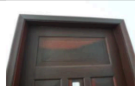
APTO. 303 : ACESSO SOCIAL SEM IDENTIFICAÇÃO
