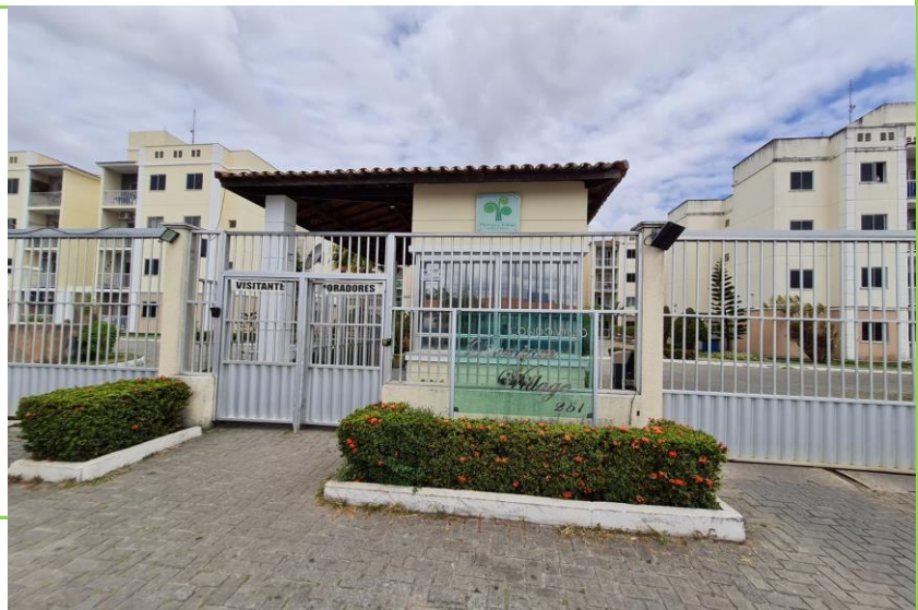
Foto da Fachada do Imóvel
