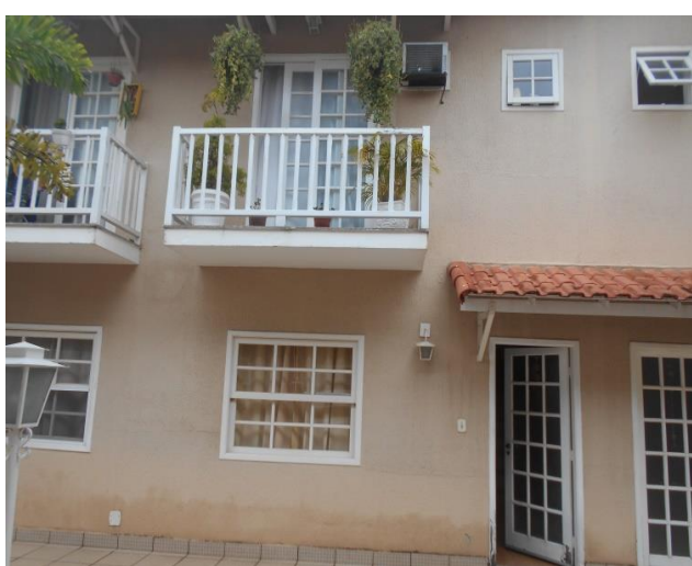
FACHADA DO AVALIANDO
