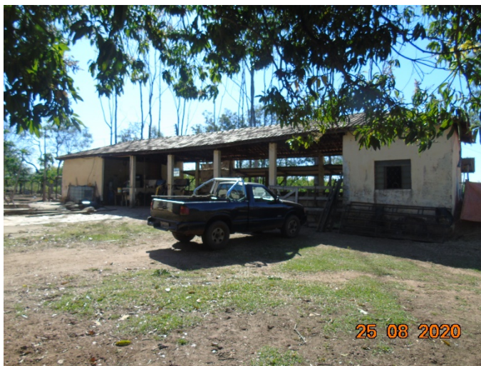
Foto 08. Galpão de depósito e abrigo de equipamentos
