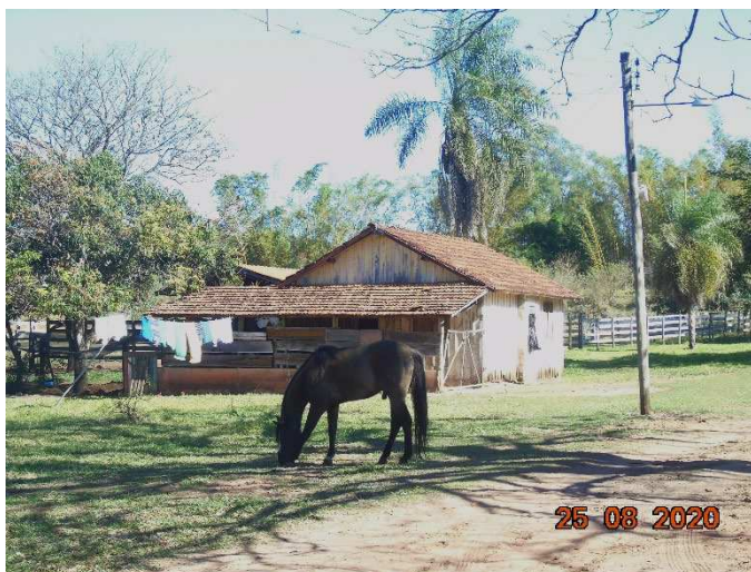
Foto 04. Vista posterior da casa de madeira sem uso
