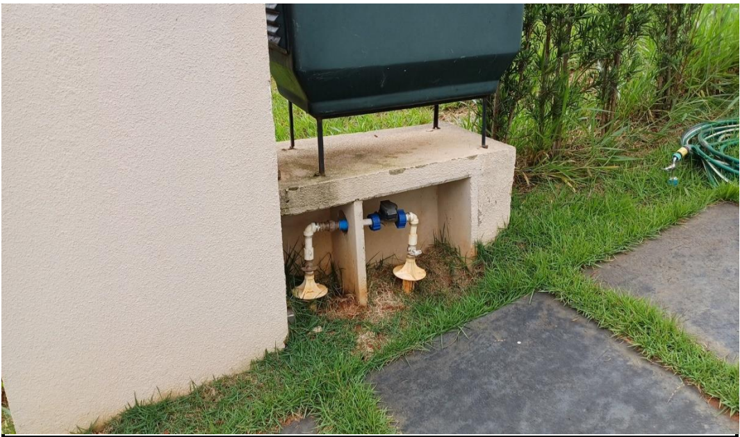
Descrição: VISTA PARCIAL INTERNA DO IMÓVEL
