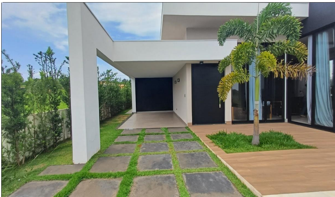
Descrição: VISTA PARCIAL INTERNA DO IMÓVEL
