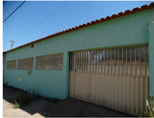
FACHADA DO AVALIANDO
