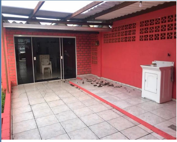
VARAND/ÁREA DE SERVIÇO
