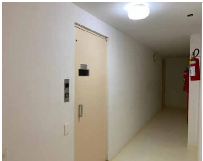
Elevador de serviço
