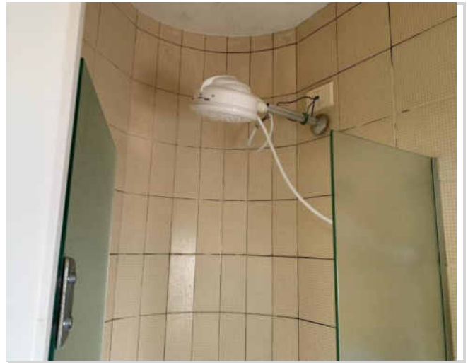
Banheiro de serviço
