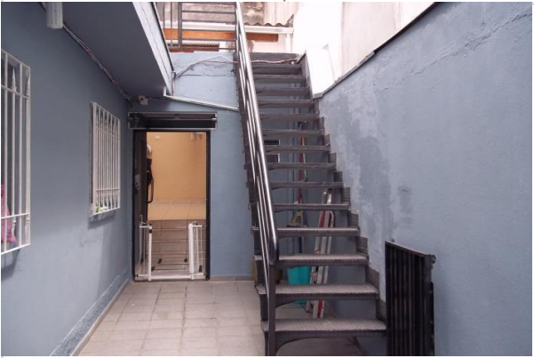
Acesso ao 2º pavimento
