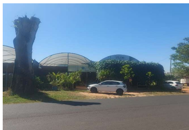
Fachada do avaliando - Vista 01
