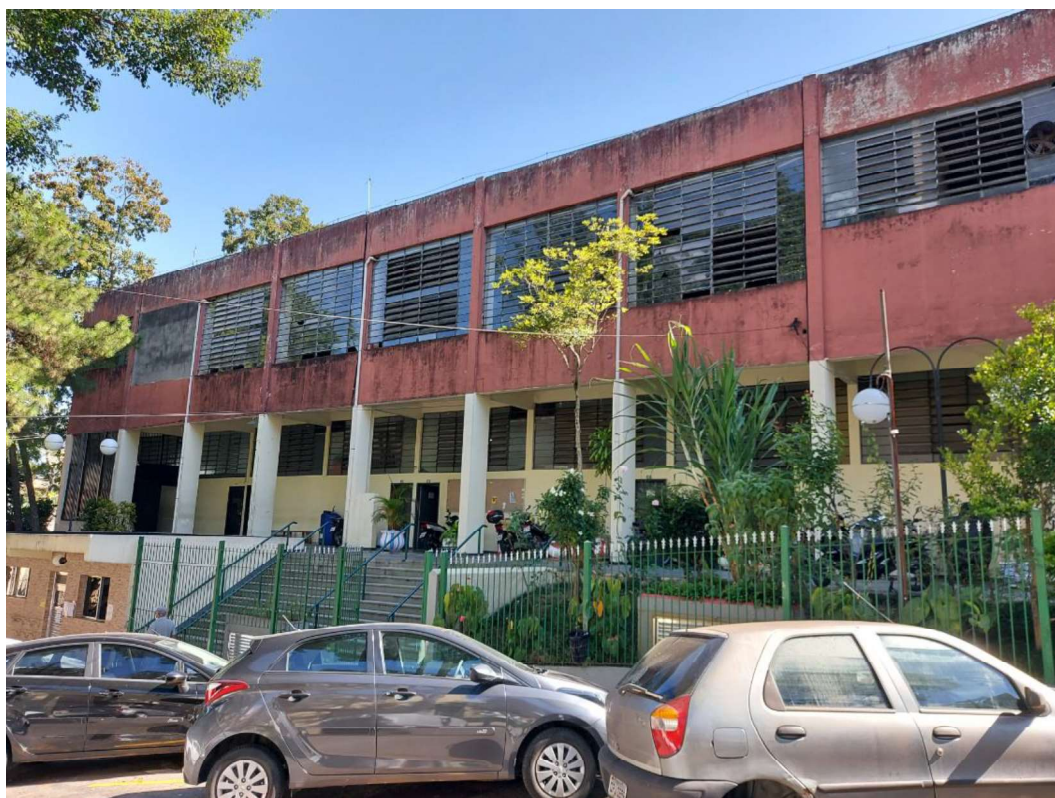
Centro Administrativo e Comunitário
