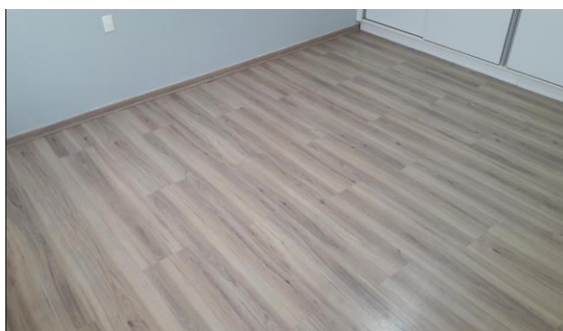
Descrição: Vista parcial do imóvel
