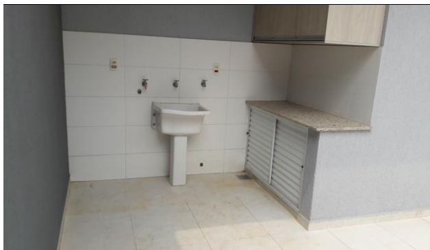
Descrição: Vista parcial do imóvel
