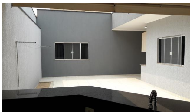
Descrição: Vista parcial do imóvel
