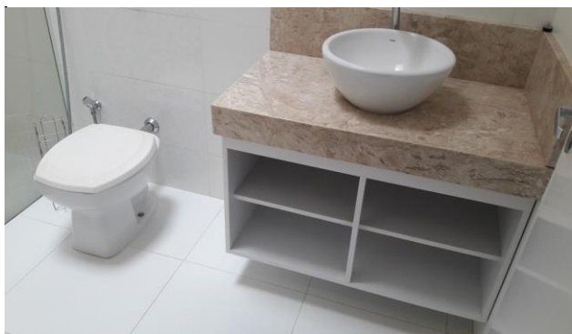
Descrição: Vista parcial do imóvel
