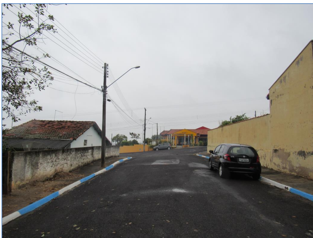
ALAMEDA DAS MARGARIDAS, NO TRECHO ONDE SE LOCALIZA O IMÓVEL.
