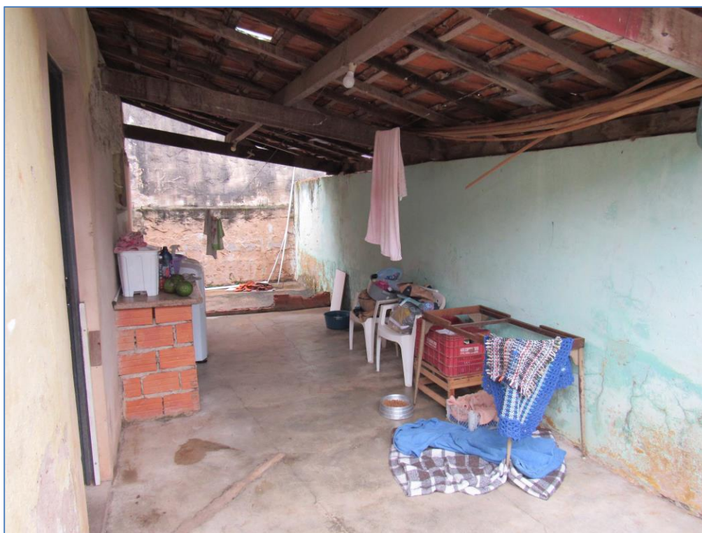
OUTRA VISTA DA ÁREA DE SERVIÇO / ÁREA COBERTA.
