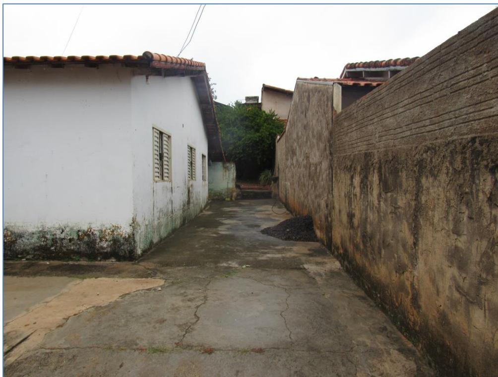
RAMPA DE ACESSO - GARAGEM.
