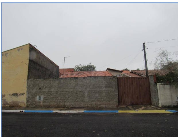
FACHADA DO IMÓVEL AVALIANDO.
