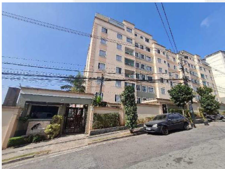
Figura 1 – Fachada do Condomínio Itacolmi - Fonte: Própria (26.07.2022)
