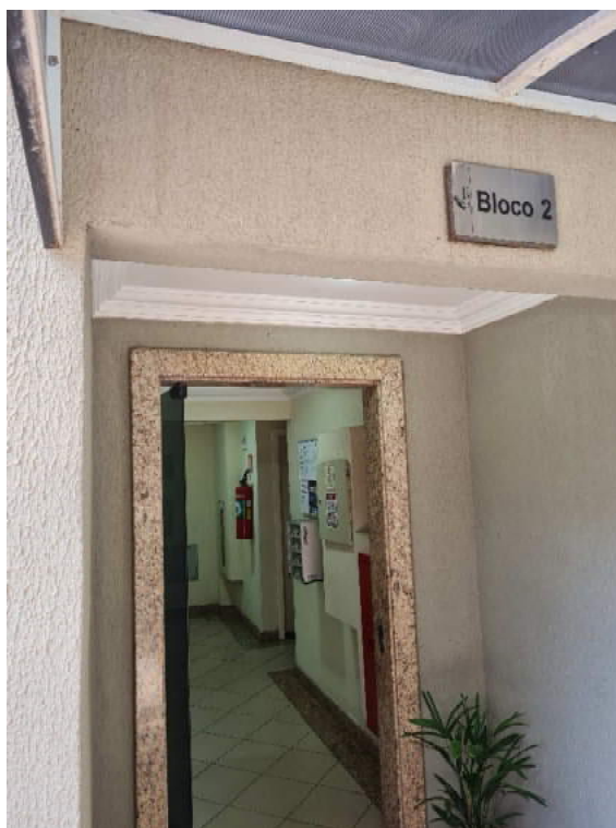
Figura 8 – Acesso ao bloco 2 – Fonte: Própria (26.07.2022)
