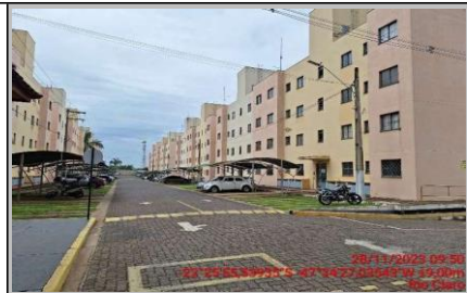
F04: Vista Parcial Interna do Condomínio
