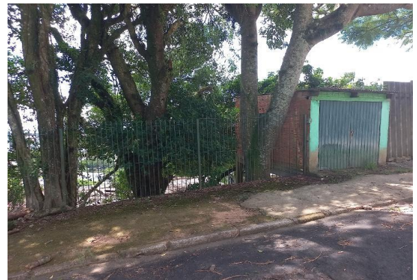
Fachada avaliando - Vista 03
