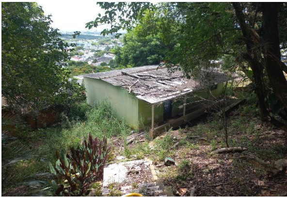
Fachada avaliando - Vista 02
