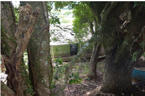
Fachada avaliando - Vista 04
