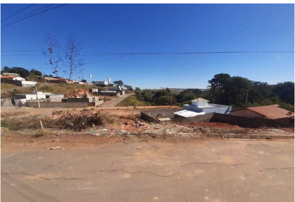
Fachada do avaliando
