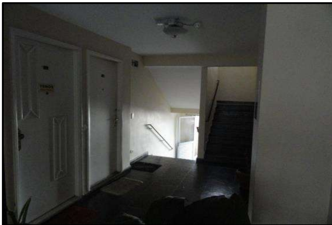
FOTO 9 – Vista do hall do pavimento térreo.
