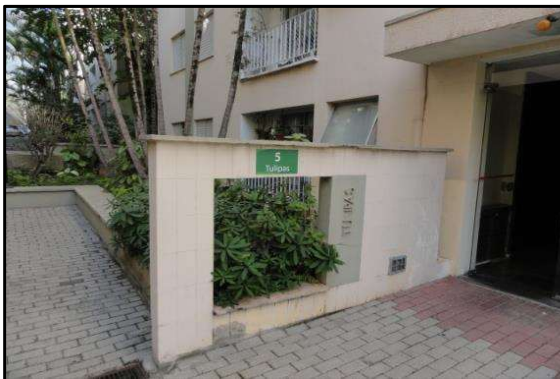
FOTO 8 – Vista do acesso ao Edifício Tulipas.
