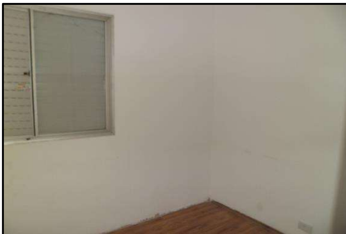
FOTO 14 – Vista do dormitório.
