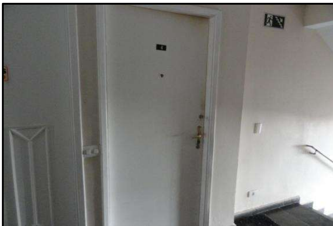
FOTO 10 – Vista da porta de acesso ao imóvel avaliando.
