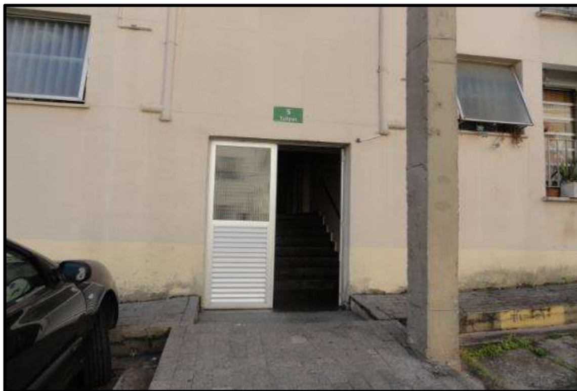
FOTO 7 – Vista do acesso ao Edifício Tulipas.
