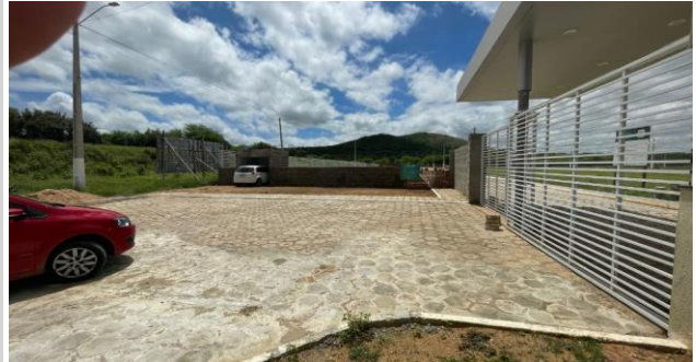
Logradouro externo, vista 02
