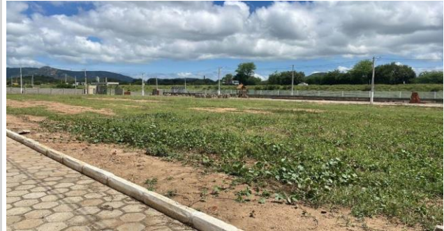
Vizinho à direita - Fachada
