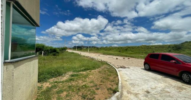
Logradouro externo, vista 01
