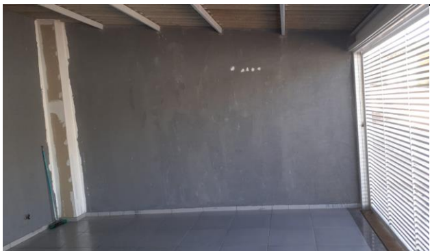
Descrição: VISTA PARCIAL INTERNA DO IMÓVEL
