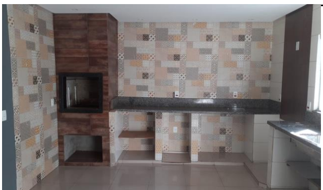
Descrição: VISTA PARCIAL INTERNA DO IMÓVEL
