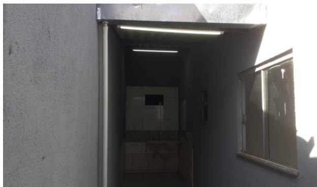
Descrição: VISTA PARCIAL INTERNA DO IMÓVEL
