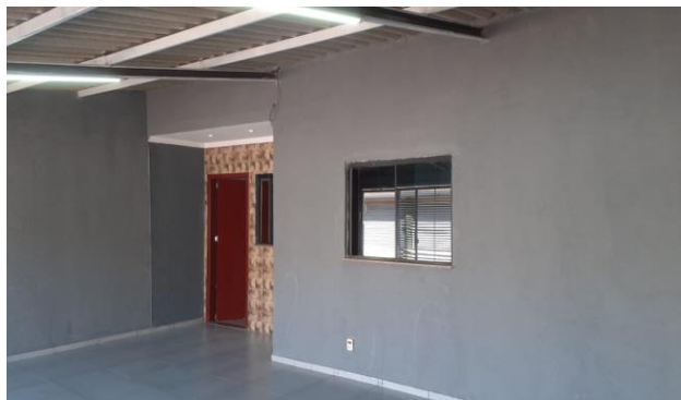
Descrição: VISTA PARCIAL INTERNA DO IMÓVEL
