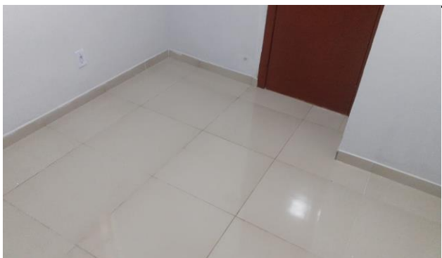
Descrição: VISTA PARCIAL INTERNA DO IMÓVEL
