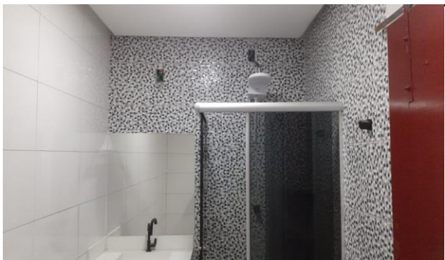
Descrição: VISTA PARCIAL INTERNA DO IMÓVEL
